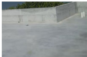
Gambar 1.11 Dak beton yang berfungsi juga sebagai atap
