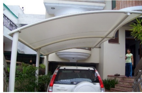
Gambar 1.14 Memeriksa kondisi atap
