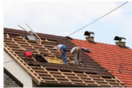
Gambar 1.3 Memasang genteng tanah liat
