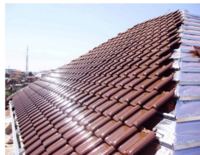
Gambar 1.4 Genteng keramik dengan konstruksi atap kayu dan baja ringan
