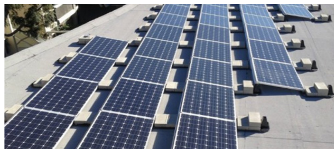
Gambar 1.27 Pemasangan Modul surya di atas atap beton cor menggunakan sistem ballasted and non-penetration sistem
