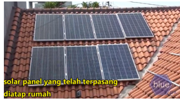
Gambar 2.8 Solar panel dipasang sesuai layout yang direncanakan sebelumnya
