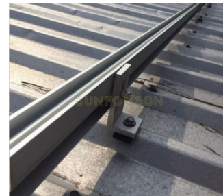
Gambar 2.3a Pemasangan L -Feet pada atap seng
