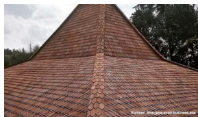
Gambar 1.6 Pemasangan atap sirap pada bangunan joglo
