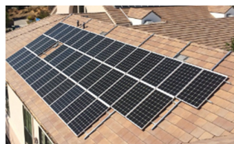
Gambar 1.28 Pemasangan Modul Surya Sistem Railing di atas genteng jenis Bitumen
