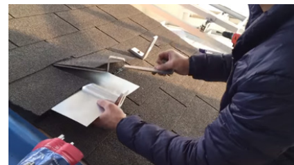
Gambar 2.5 Pemasangan plat pelindung kebocoran
