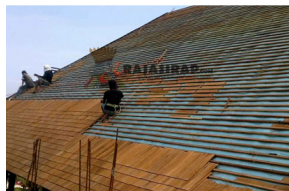
Gambar 1.7 Pemasangan atap sirap bahan aspal bitumen pada konstruksi atap kayu
