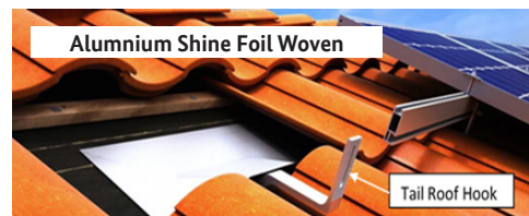
Gambar 2.1 Pemasangan Tile Roof Hook pada Genteng
