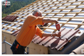
Gambar 1.10 Pemasangan Genteng Bitumen Bergelombang
