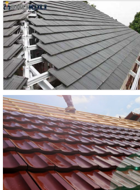
Gambar 1.5 Genteng beton dengan konstruksi atap kayu dan baja ringan
