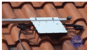
Gambar 2.7 Micro Inverter dipasang di bawah plat dudukan
