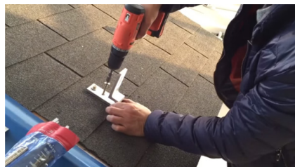
Gambar 2.4 Pemasangan tileRoof Hook pada atap aspalt bitumen
