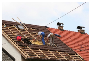
Gambar 1.16 Memperbaiki atap yang rusak sebelum memasang dudukan modul surya
