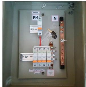
Panel distribusi AC dipasang antara inverter dan KWH Meter EX-Im. Di dalam panel ini terdapat MCB pada setiap phase yang keluar dari inverter. Kabel phase dari inverter on-grid dipasang pada terminal input MCB yang terletak di sebelah atas, tidak boleh terbalik!. Jika terbalik, ketika terjadi arus lebih akan timbul timbul busur api pada MCB yang mengakibatkan MCB menjadi terbakar dan rusak. Gambar berikut menunjukkan pemasangan kabel AC dari inverter yang benar dan salah. Lihat gambar di bawah.
