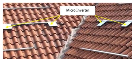
Gambar 2-15 Micro Inverter dipasang pada Rail sebelum Module Surya terpasang
